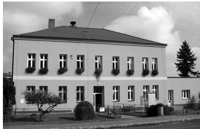
ÚŘAD V ČERVENÝCH JANOVICÍCH prošel velkou opravou. Dočkal se zateplení, výměny oken a topného systému. Práce pomohly mimo jiné k hezčímu vzhledu celé obce. Foto: archiv Červených Janovic
